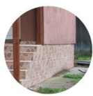
Aplicare pe soclu: tencuieli pe bază de ciment sau tencuieli decorative mozaicate, similipiatră sau plăci ceramice
