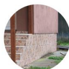
Aplicare pe soclu: tencuieli pe bază de ciment sau tencuieli decorative mozaicate, similipiatră sau plăci ceramice
