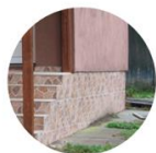
Aplicare pe soclu: tencuieli pe bază de ciment sau tencuieli decorative mozaicate, simlipiatră sau plăci ceramice
