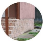
Aplicare pe soclu: tencuieli pe bază de ciment sau tencuieli decorative mozaicate, similitră sau plăci ceramice
