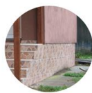
Aplicare pe soclu: tencuieli pe bază de ciment sau tencuieli decorative mozaicate, similpiatră sau plăci ceramice
